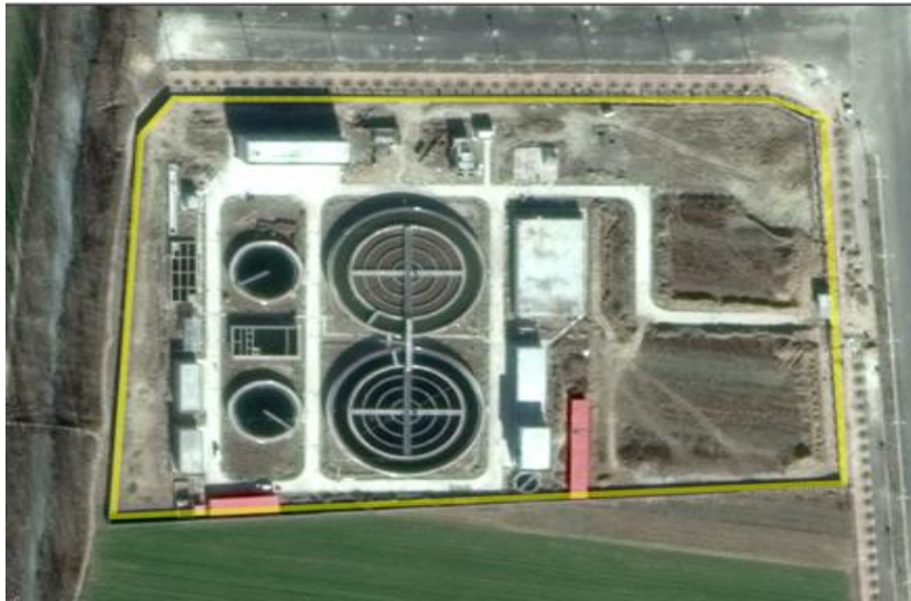
图 5-2 新尉工业园污水处理厂全景
