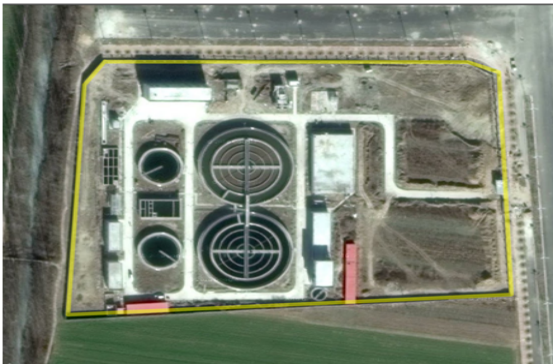
图 2-2 新尉工业园污水处理厂全景
